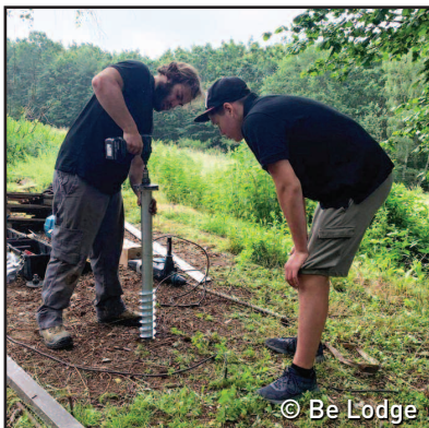
Vis de fondation mise en œuvre manuelle
